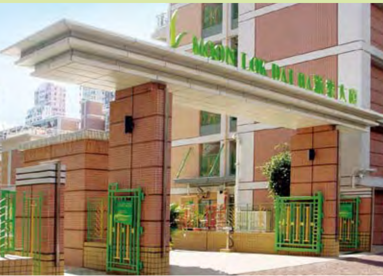
復修後的滿樂大廈煥然一新
