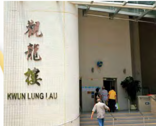
觀龍樓的穿梭升降機大樓，免除居民拾級出入的不便
