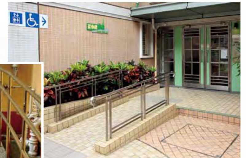
滿樂大廈的大堂出入口加建輪椅斜道
