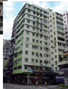
大廈進行維修後
