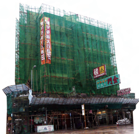
受惠於「樓宇更新大行動」的大廈進行維修工程
