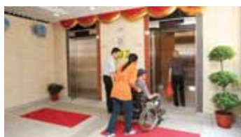
為舊屋邨大樓增設升降機，方便長者居民上落
